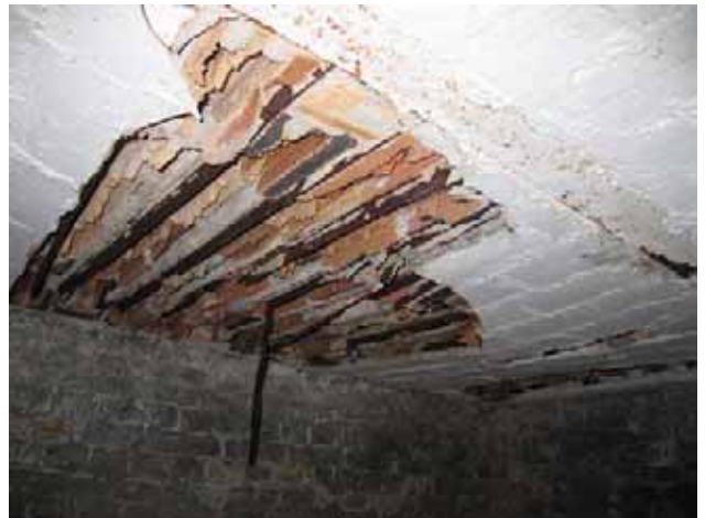
Keller Decke u. Treppenhaus. Nord-Ost
