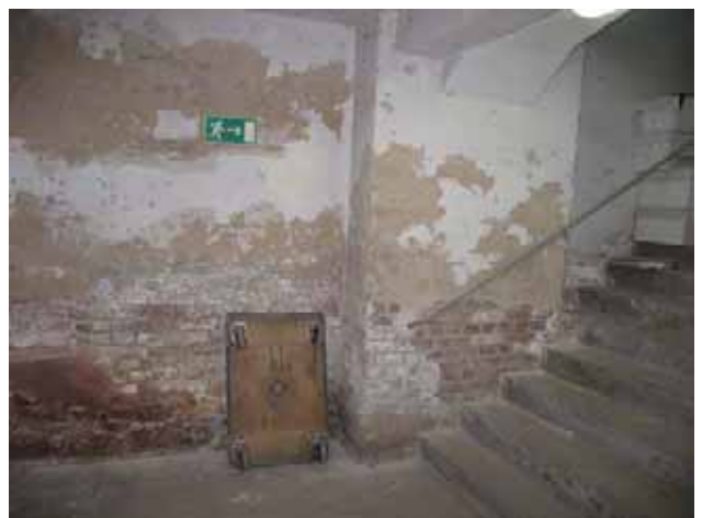
Keller Wände Aufgang Süd-West
