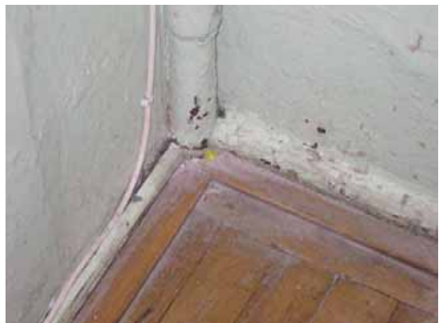
Wand und Boden Raum 0.03 / EG
