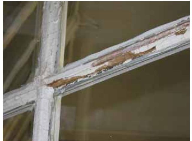
Fenster innen, Raum 1.04
