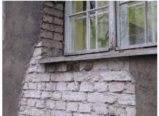
Fenster Hoffassade, Raum 415
