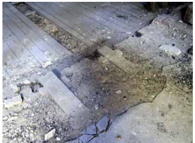
Dachboden Schüttung, Estrich
