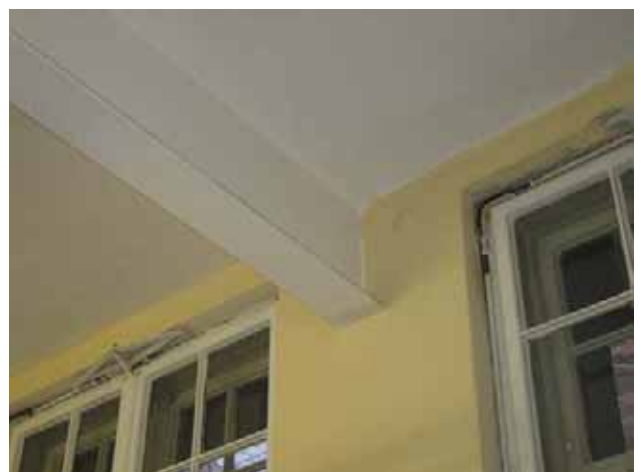
Stahlunterzüge z.B. Raum 1.05 / 1.OG
