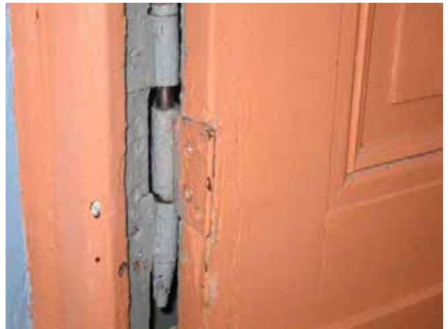
Tür Raum 1.05 / 1.OG
