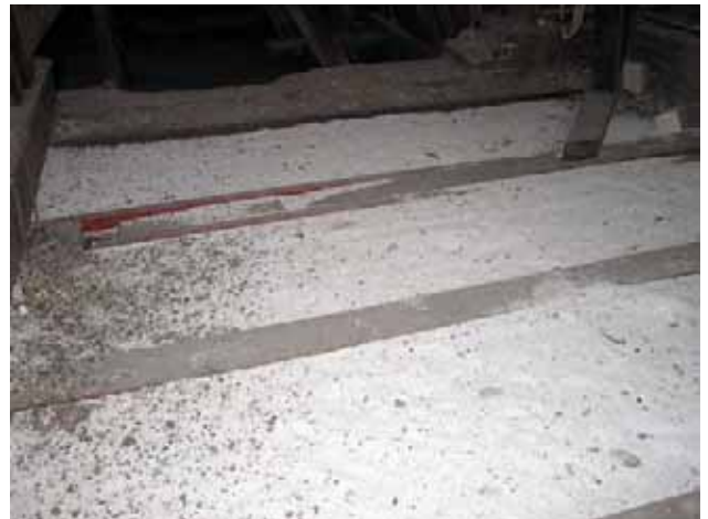
Dämmende Schüttung über Aula
